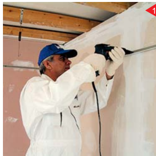
نصب سازه نبشی تراز سقف
