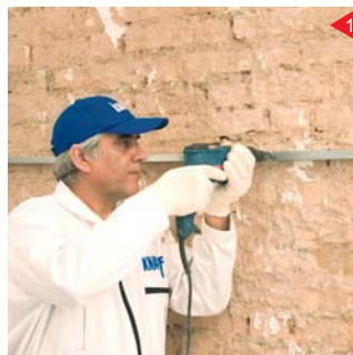
نصب سازه نبشی تراز سقف
