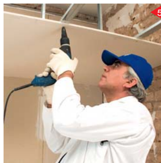
نصب صفحات به سازه
