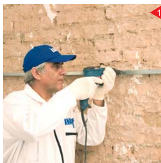
نصب سازه نبشی تراز سقف
